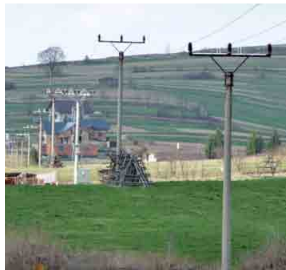
Cieľom SSE je znížiť riziká zranení a úmrtí vtáctva na stĺpoch elektrického vedenia.
